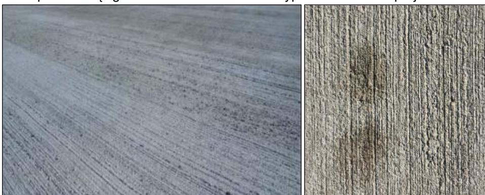
Betono paviršius brauktas šepečiu
